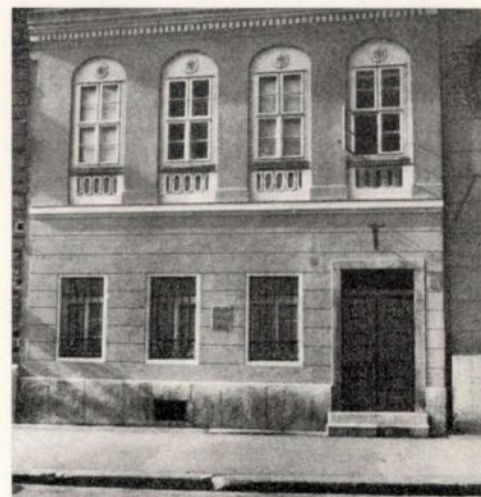
2. A helyreállított Tárnok utcai homlokzat
