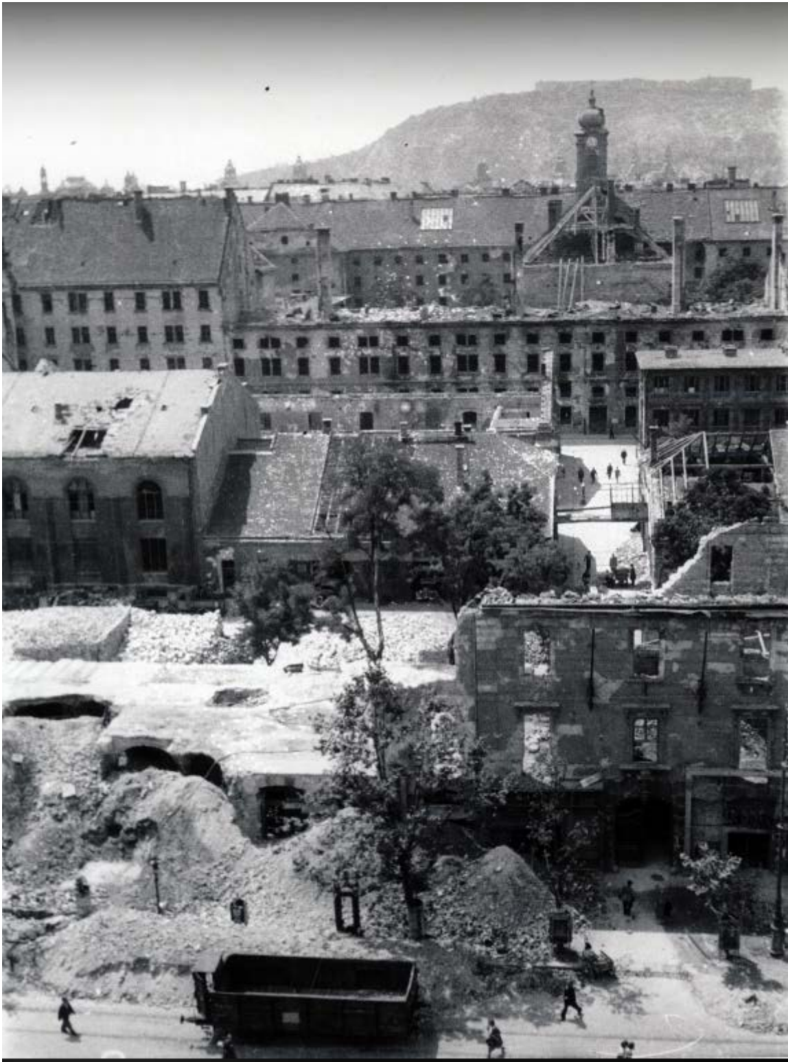
1. kép. A városháza Károly körút felé eső frontja és a keresztszárny 1945-ben teljesen kiégett, vele együtt pusztultak a levéltári és irattári iratok. (Fotó: Fortepan / Fortepan)
