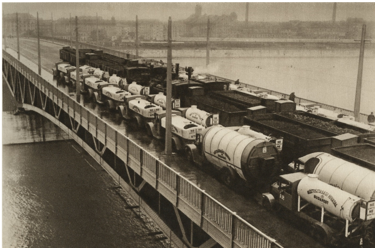
3. kép. A mederhíd próbaterhelése. (In: A Horthy Miklós híd 1933–1937. )
