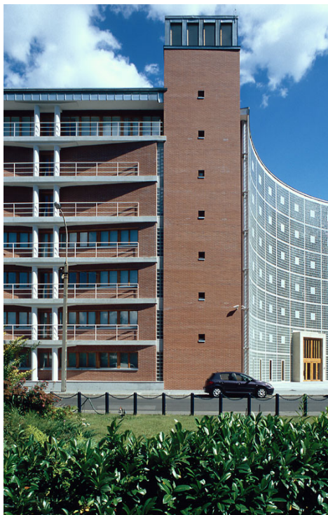
A levéltár épülete (BFL XV.19.c.4)
